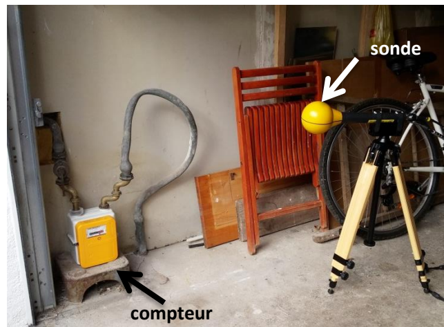
Figure 12 : installation du compteur Gazpar chez un particulier de Rueil-Malmaison
