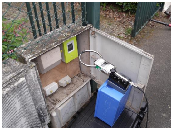
Photo 9. Champ magnétique horizontal sur site
